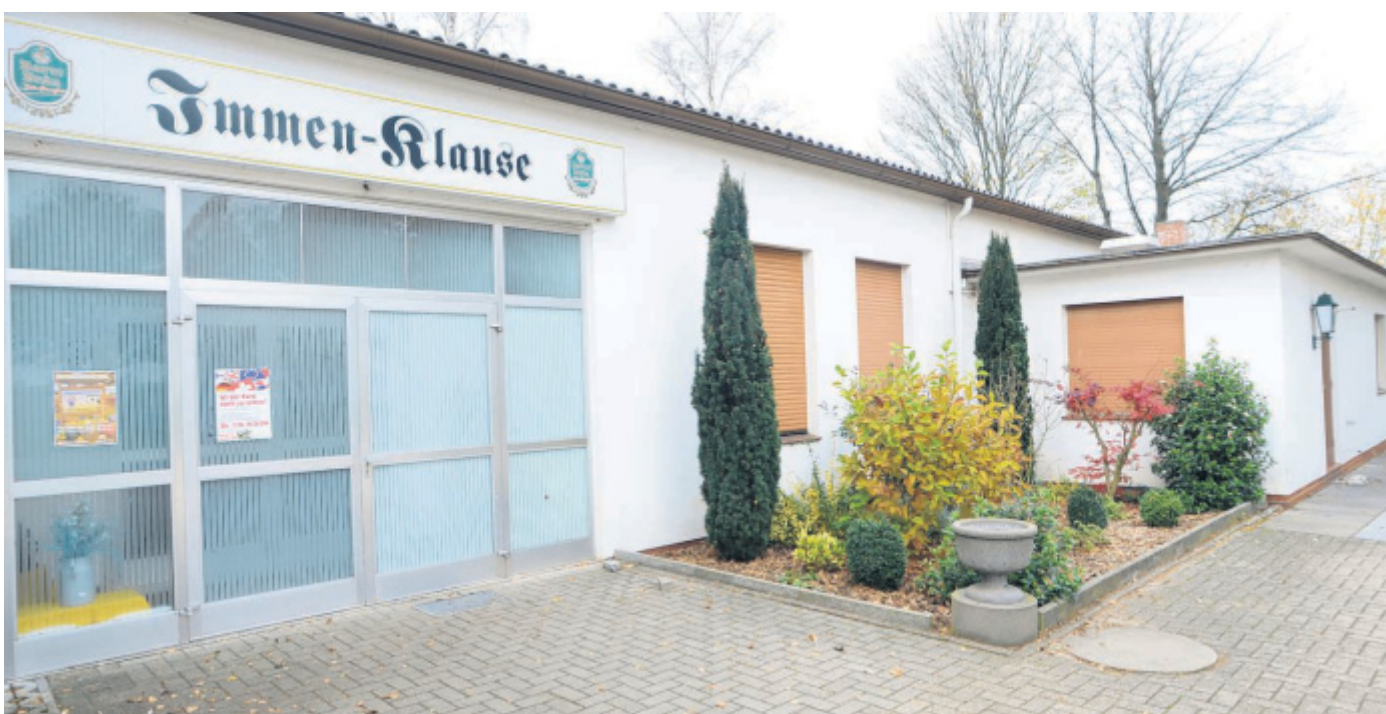
In die Jahre gekommen: Die Immenklause dient als Schützenhalle, konnte bislang aber auch von Privatpersonen als Feierhalle genutzt werden. Die Zukunft der kommunalen Halle sorgte für Debatten im Ausschuss.
